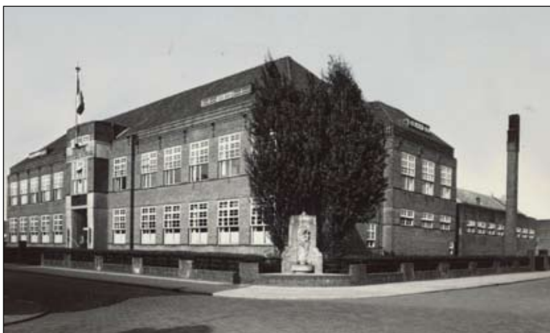
Het gebouw van de Textielschool (de latere Hogere Textielschool) aan de toenmalige Lange Schijfstraat hoek Schoolstraat. Anno 2008 is dit Noordhoekring en is hier de Nieuwste School in gehuisvest. Foto 1952. (Coll. RAT).
