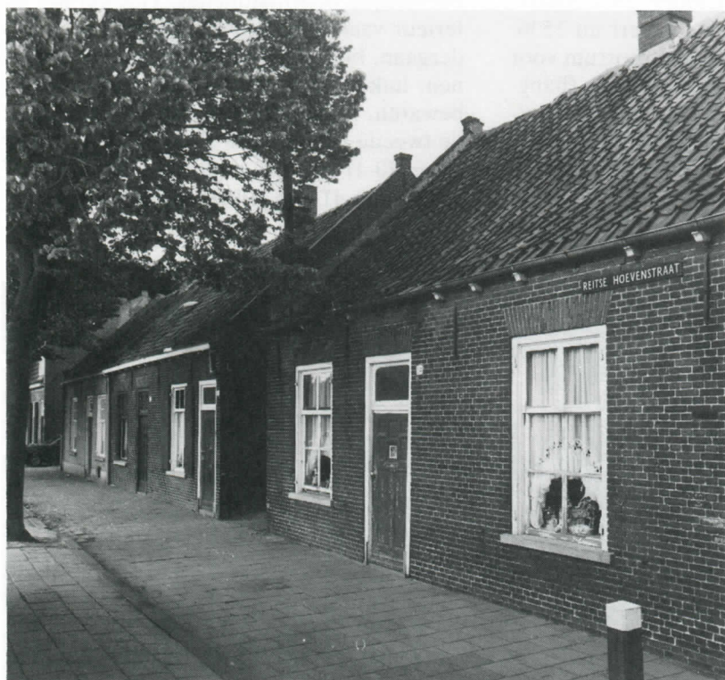
Afb. 6 Rij weverwoningen Reitse Hoevenstraat 48-54 (foto Rembrandt, 1986).
