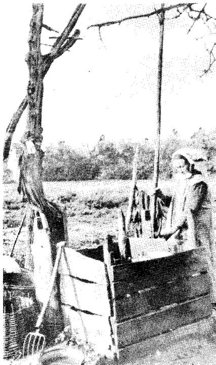
Put. Dit is de primitiefste vorm. De putkùip is van ruwe planken onbeholpen in elkaar geflanst. In betere tijden werden de putkùip en de put zelf gemetseld. Nog later werd bij geconstrueerd uit betonringen. Duidelijk zichtbaar zijn hier de mik, de zwèngel en het hoefijzer.
