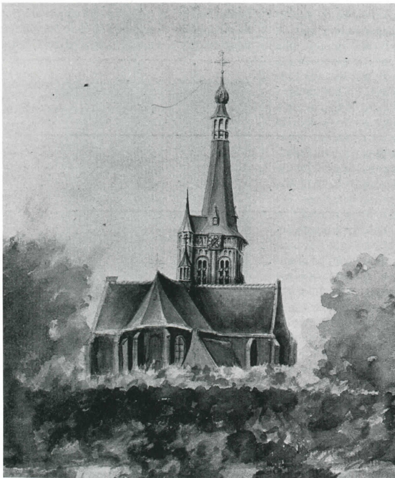
afb. 6 Achterzijde van de Heikese kerk omstreeks 1789. Sepiatekening gemaakt door F.S. 'in de tuyn van den Heer Roesingh' (part. coll. Loon op Zand).
