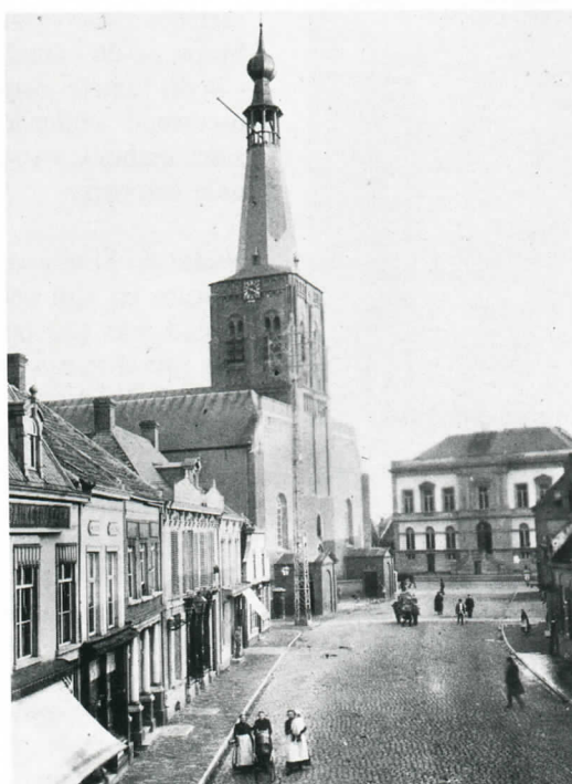
afb. 22 De waterstaatskerk voor de verbouwing van 1894-1895.
